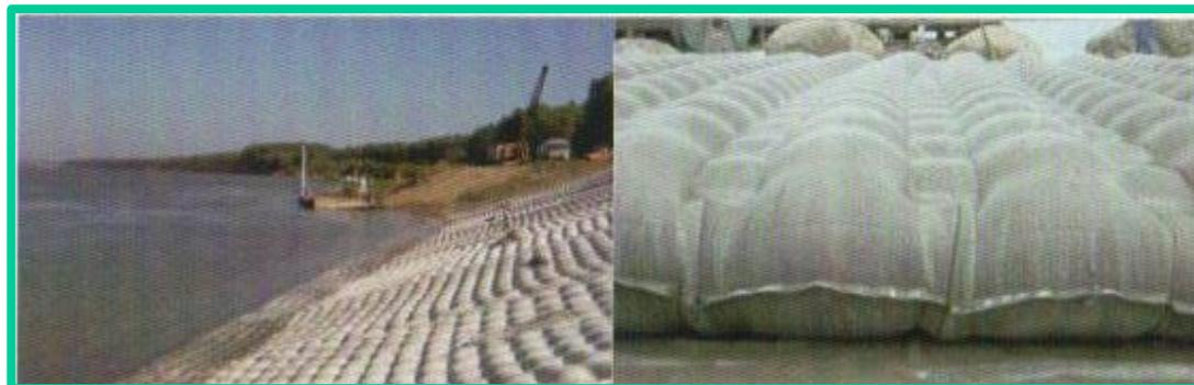
Разработка комплексных тканых систем укрепления сверхслабых грунтов на основе новых методов перераспределения нагрузок дорожного основания и совмещения функций различных материалов (разделение, армирование, фильтрация, дренаж, перераспределение пиковых нагрузок)
